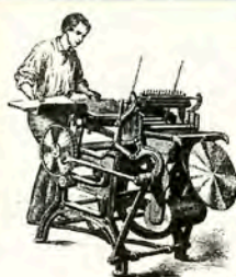
Die Doppelzylindermaschine Friedrich Koenigs für die Londoner Times, 1811 und 1813 zum Patent angemeldet.
